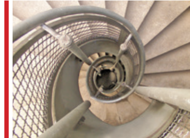
Spiral Merdiven trabzan uygulaması Spiral stairway application
